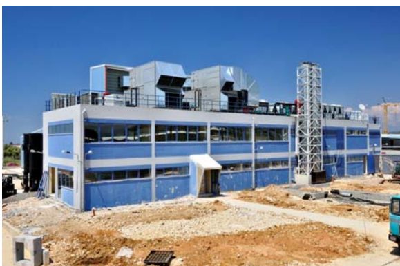
02. ΕΡΓΟΣΤΑΣΙΟ ΠΑΡΑΓΩΓΗΣ ΦΩΤΟΒΟΛΤΑΙΚΩΝ ΣΤΟΙΧΕΙΩΝ SILCIO ΑΕ
