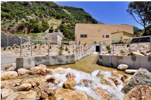
01. ΕΡΓΟΣΤΑΣΙΟ ΥΔΡΟΗΛΕΚΤΡΙΚΟΥ ΣΤΑΘΜΟΥ 5,5MW
